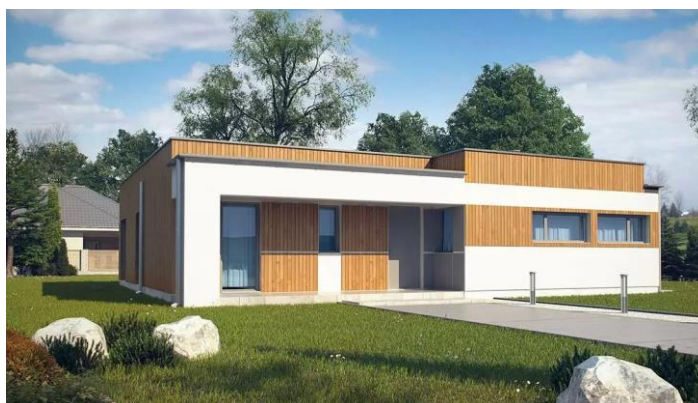
Рисунок 2.4 – Зовнішній вигляд приватного будинку
