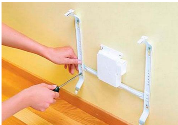
Рисунок 2.4 – Зовнішній вигляд кріплень для монтажу електричних інфрачервоних нагрівних панелей
