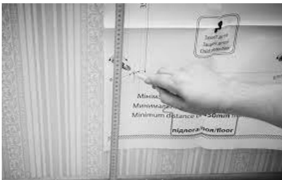
Рисунок 2.3 – Настінний шаблон для монтажу електричних інфрачервоних нагрівних панелей Terloceramic
