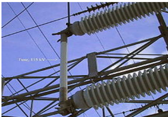
Рисунок 6.3 – Високовольтний запобіжники в ланцюгу 115 кВ
