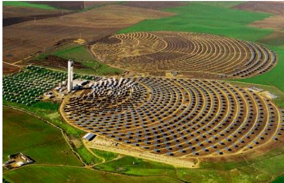
Рисунок 4.21 – Вид на станцію PS1 з висоти пташиного польоту. На задньому плані видна площадка, яку готують під PS2 (фото «Solucar»)
